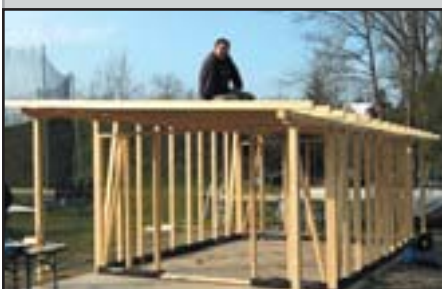
Mario Anibas beim Bau der Gerätehütte im Frühjahr 2007
